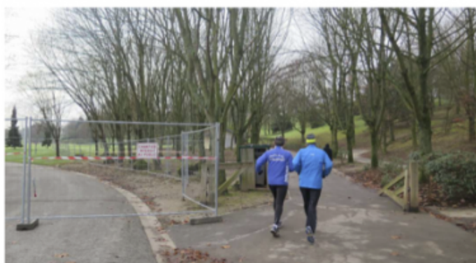
Créteil, hier. Un chantier vient de démarrer sur l'île de loisirs à Créteil pour refaire l'allée centrale qui dessert la maison de la nature et mène jusqu'au restaurant et l'école de voile. (LP/A.V.)
