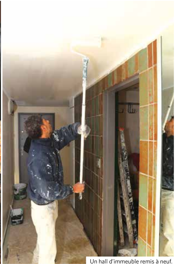
Un hall d'immeuble remis à neuf.
