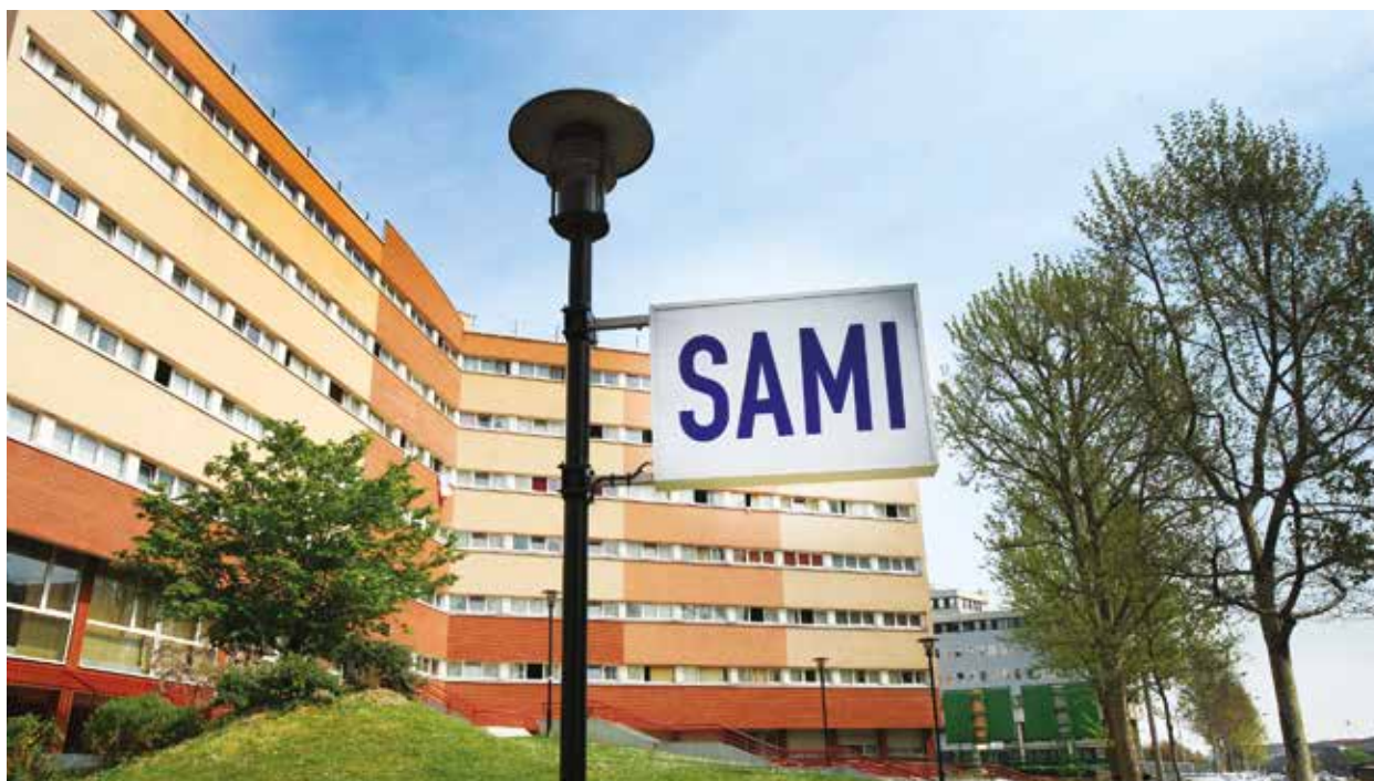
Le Sami est installé au rez-de-chaussée de l'immeuble Le Stendhal, à l'Échat.
