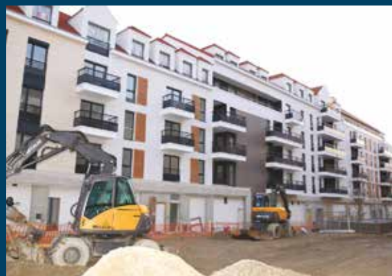
La place de la Porte de Brie, dont la construction est actuellement en cours, devra être achevée au moment de la livraison du programme de logements, en février prochain.
