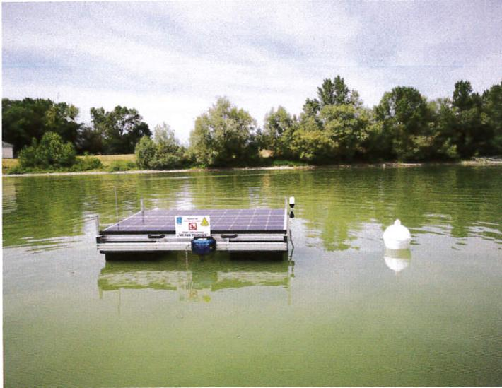
**Pour lutter contre les algues et cyanobactéries, vous pouvez installer, au centre de votre plan d'eau, une plateforme équipée d'un système d'ultrasons fonctionnant à l'énergie solaire : elle mesure 160 x 100 cm, pour un poids de 120 kg, et est lestée au fond du bassin.**
