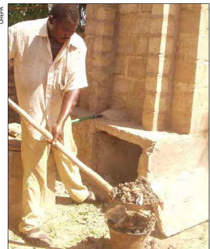
Figure 15 : vidange manuelle d'une cuve
