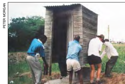
Figure 3 : déplacement de la cabine sur la nouvelle fosse
