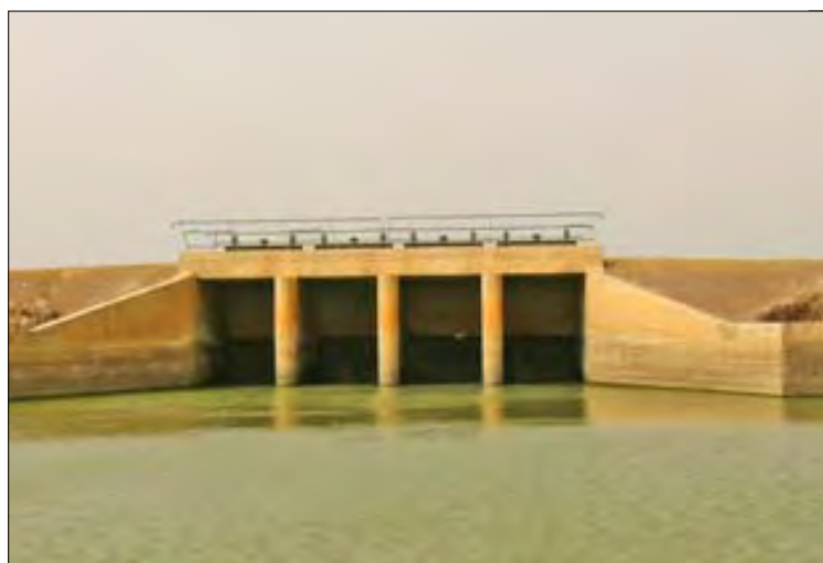
Des ouvrages sont nécessaires pour gérer l'eau (Patrick TRIPLET)
