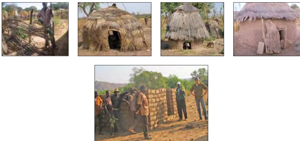
Photos 1 : des enclos traditionnels (les quatre premières photos) et un enclos amélioré en construction dans le cadre du projet ROCAL autour de la réserve de biosphère de la Pendjari (cl. E. A. Sogbohossou)
