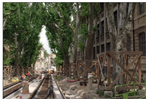
Fig. 5 - Protection des arbres lors de travaux sur voirie (A. Micand, Plante & Cité)
